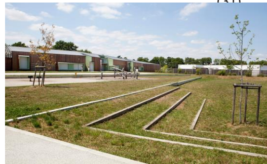
Bassin de rétention traité comme un espace public Pour une ville aimable / Grenade-sur-Garonne (31)
