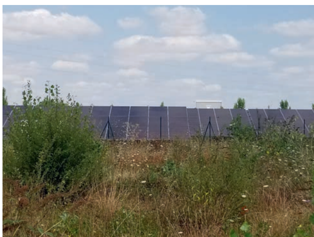
Carrière de Carbone - Réhabilitation panneaux photo-voltaïque -HGI
