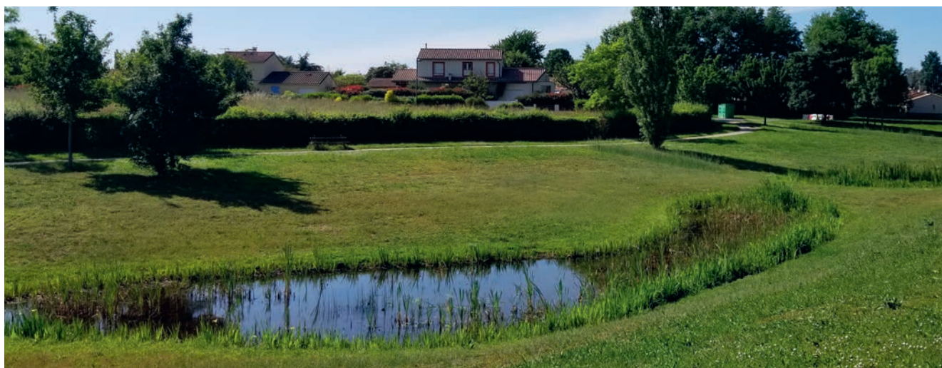
Bassin de rétention planté de traitement du pluvial du quartier des logis à Carbonne - HGI
