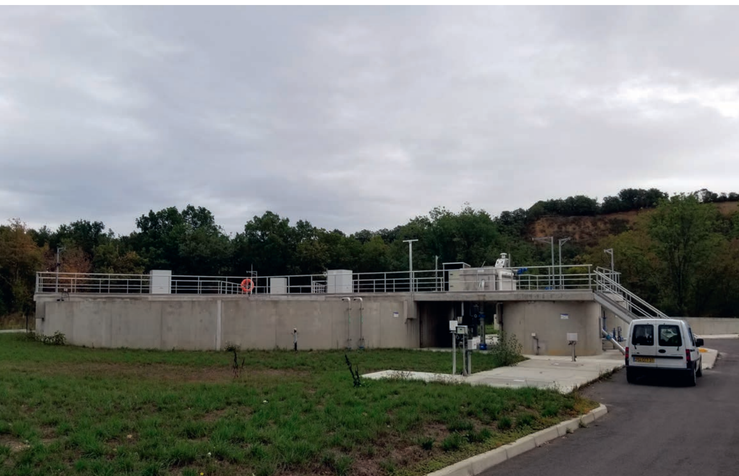
Station de traitement des eaux usées de Carbonne - Marqufave mise en service en 2019
