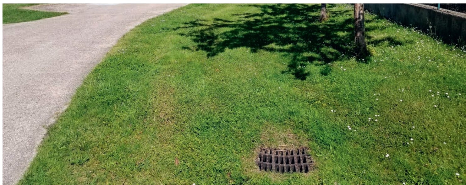
Trottoirs enherbés avec récupération des eaux pluviales - Quartier des logis à Carbonne - HGI
