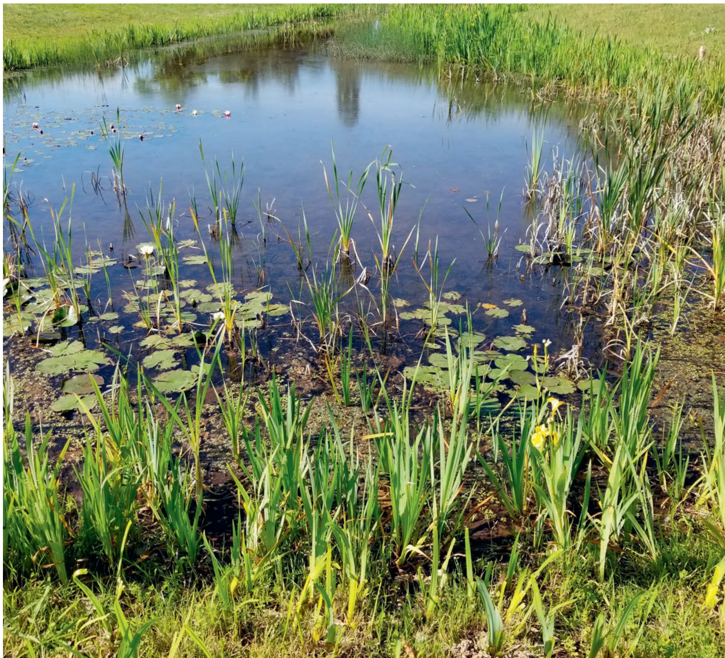
Bassin de rétention pluviale planté et accueillant une biodiversité dont des poissons et des grenouilles pour empêcher les moustiques- Quartier des logis à Carbone - HGI
