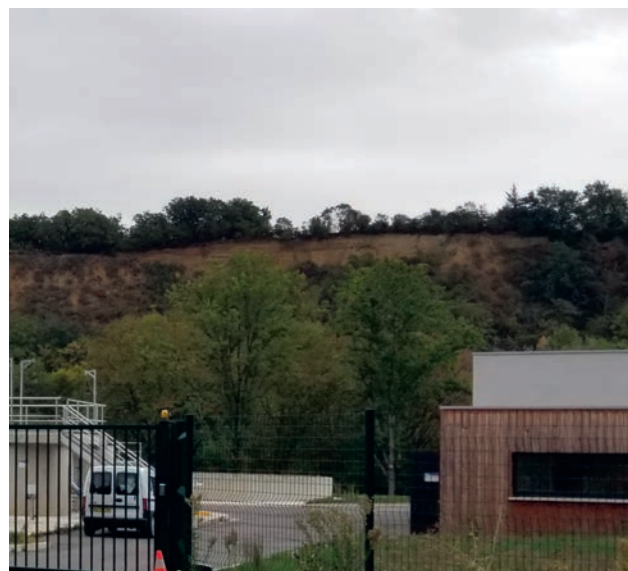
Érosion des berges de la Garonne au dessus de la STEU de Carbonne
