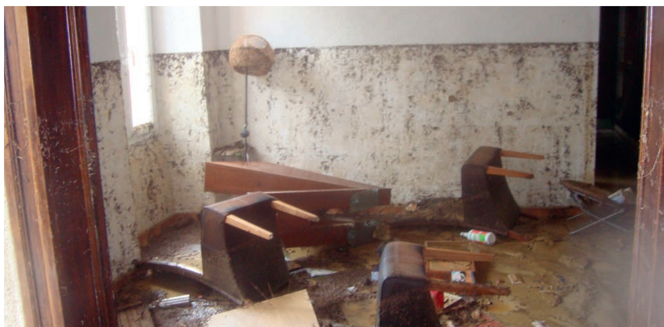
Les dégâts dans les maisons après l'inondation du 16 juillet 2018 à Gaillac-Toulza - Mairie de Gaillac-Toulza
