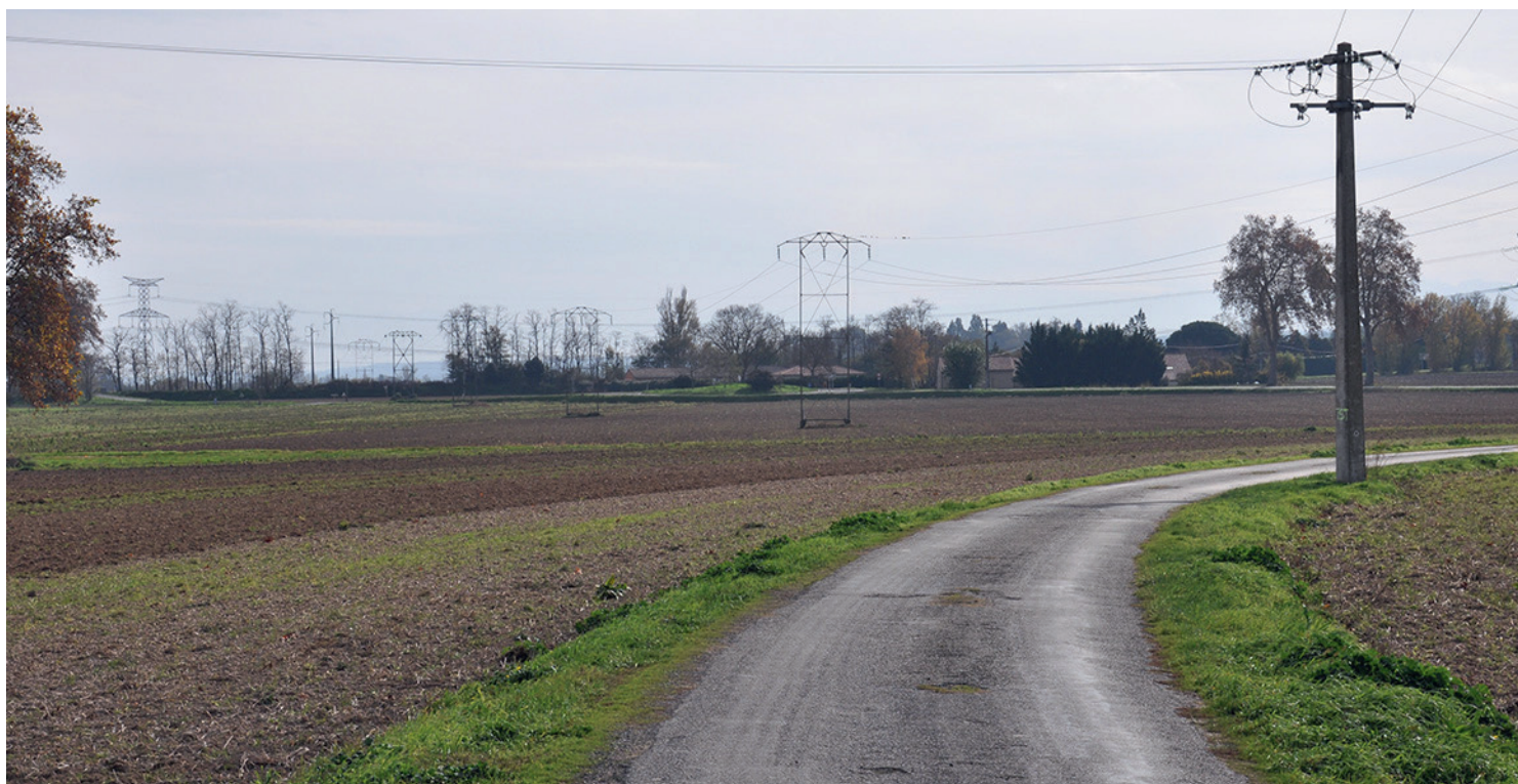
Infrastructure électrique en plaine à Lagardelle-sur-Lèze - Atlas des paysages de la Haute-Garonne
