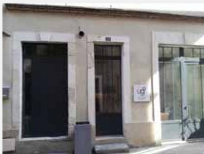
Cazères Tiers Lieu opérationnel en 2017 Gestion privée : Relais d'Entreprises 4 bureaux individuels
