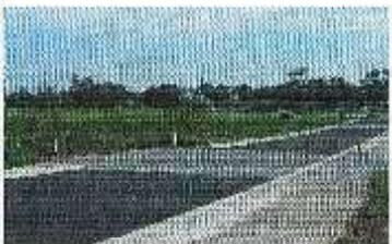
Des tables de drainage permettent de gérer les eaux de pluie et de réduire les risques d'inondation.
