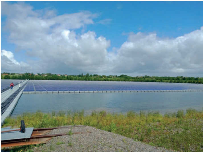
Installation photovoltaïque flottant sur une ancienne gravière en eau - Peyssies
