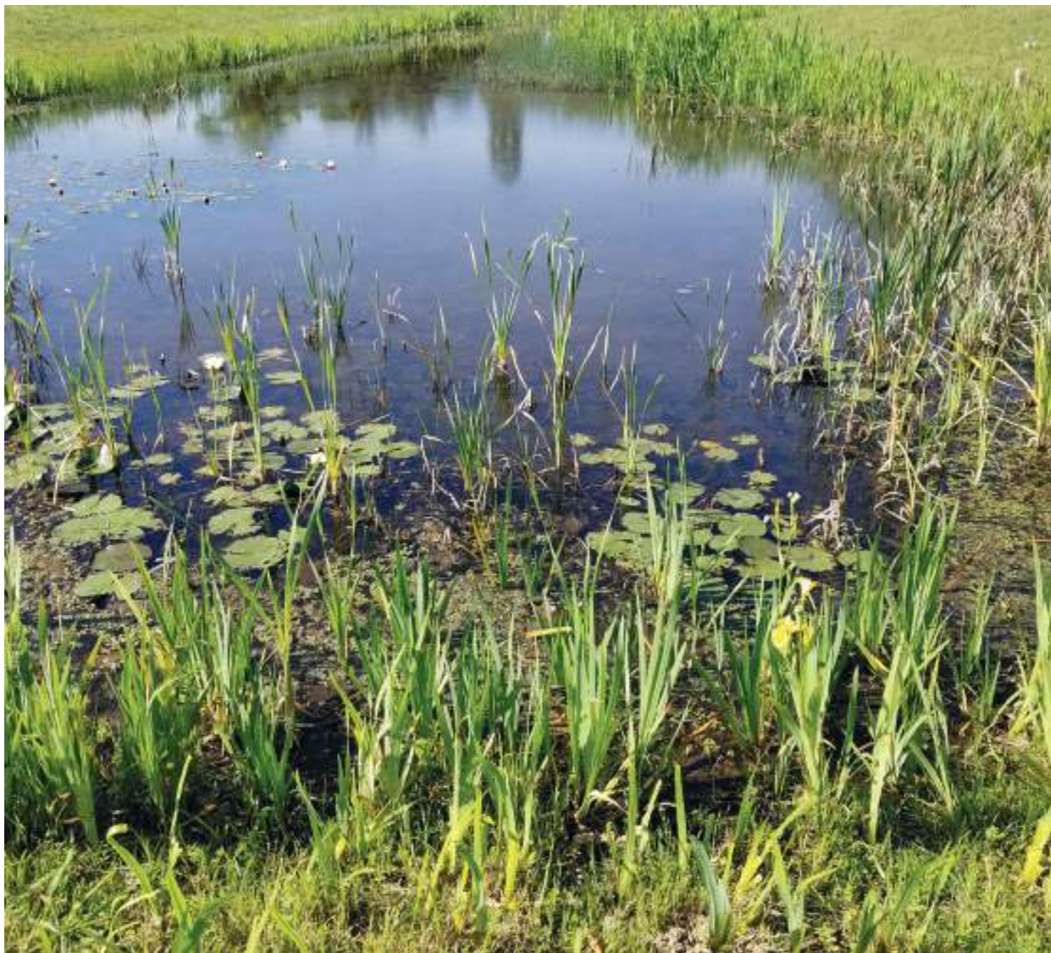
Bassin de rétention pluviale planté et accueillant une biodiversité dont des poissons et des grenouilles pour empêcher les moustiques- Quartier des logis à Carbonne - HGI
