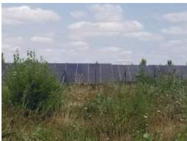
Carrière de Carbone - Réhabilitation panneaux photo-voltaïque -HGI
