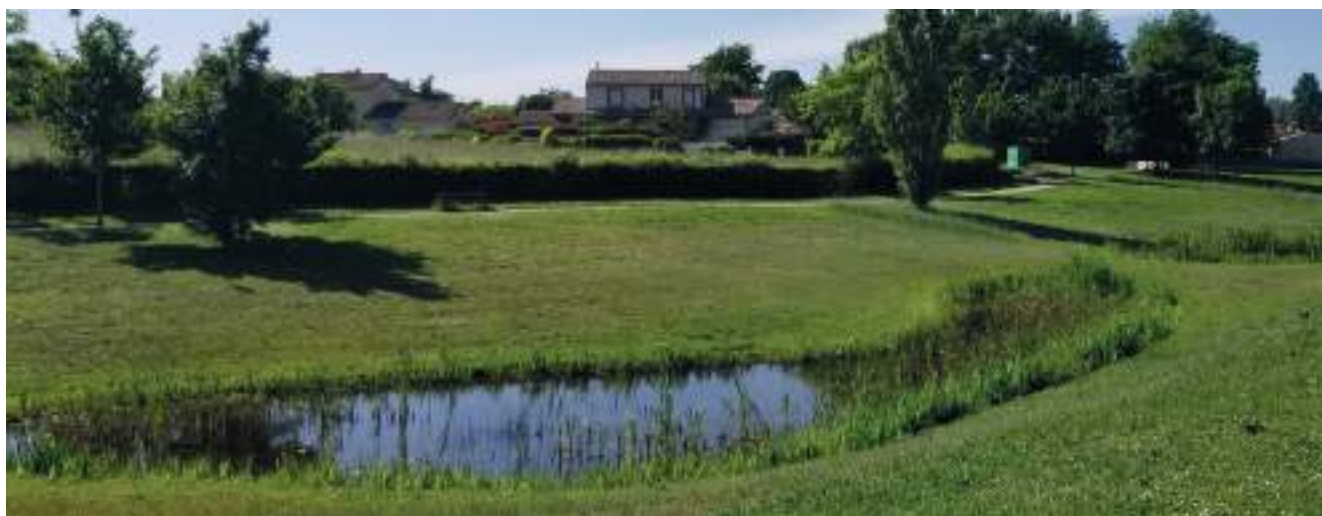
Bassin de rétention planté de traitement du pluvial du quartier des logis à Carbone - HGI
