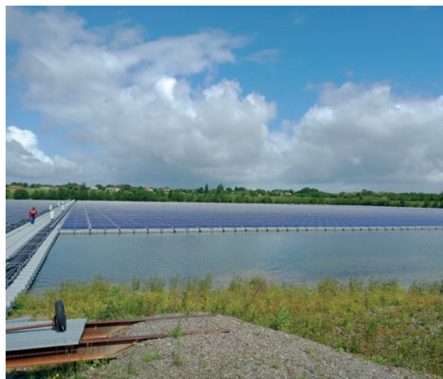
Installation photovoltaïque flottant sur une ancienne gravière en eau - Peyssies
