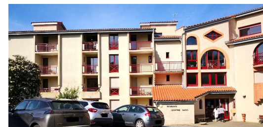
Projet Géothermie, foyer Léontine 35 Naves (CCAS), Le Fousseret
